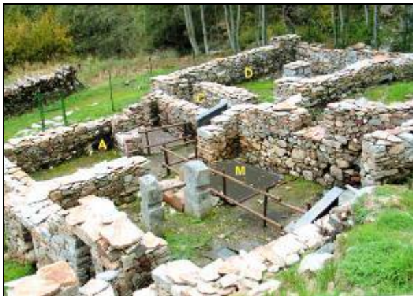
Alcuni vani dopo il restauro
