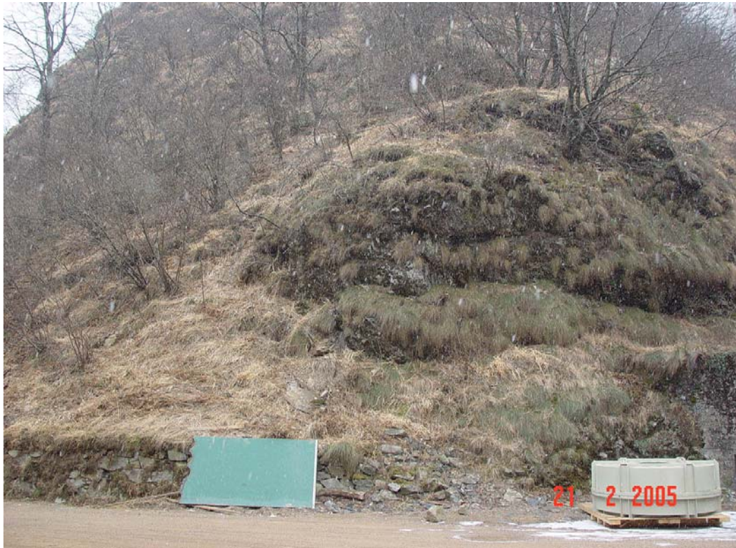
Punto d'imbocco della nuova galleria di derivazione
