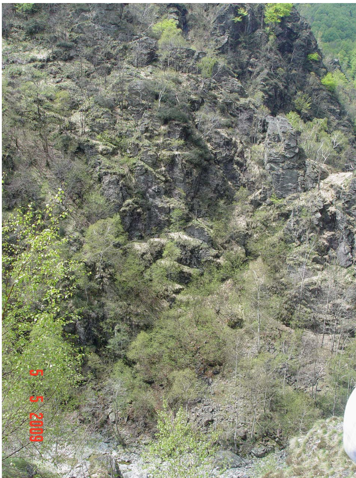
Vista della sponda destra in corrispondenza della sezione d'imposta
