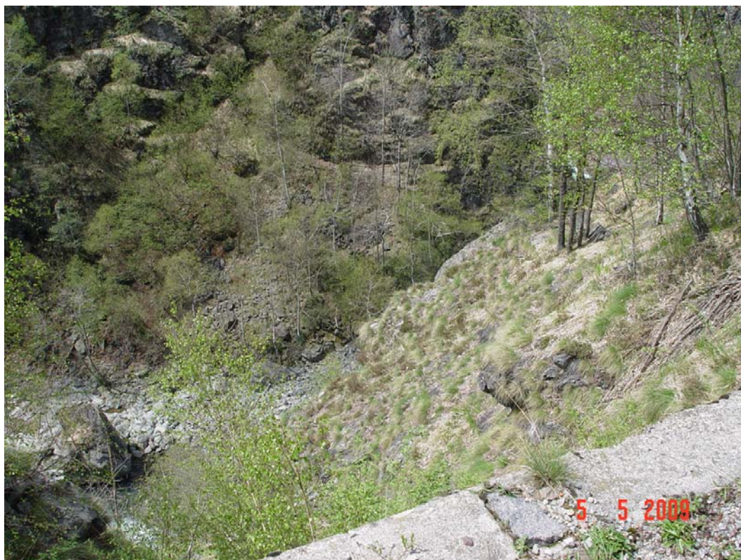
Alveo in corrispondenza della sezione d'imposta della nuova diga
