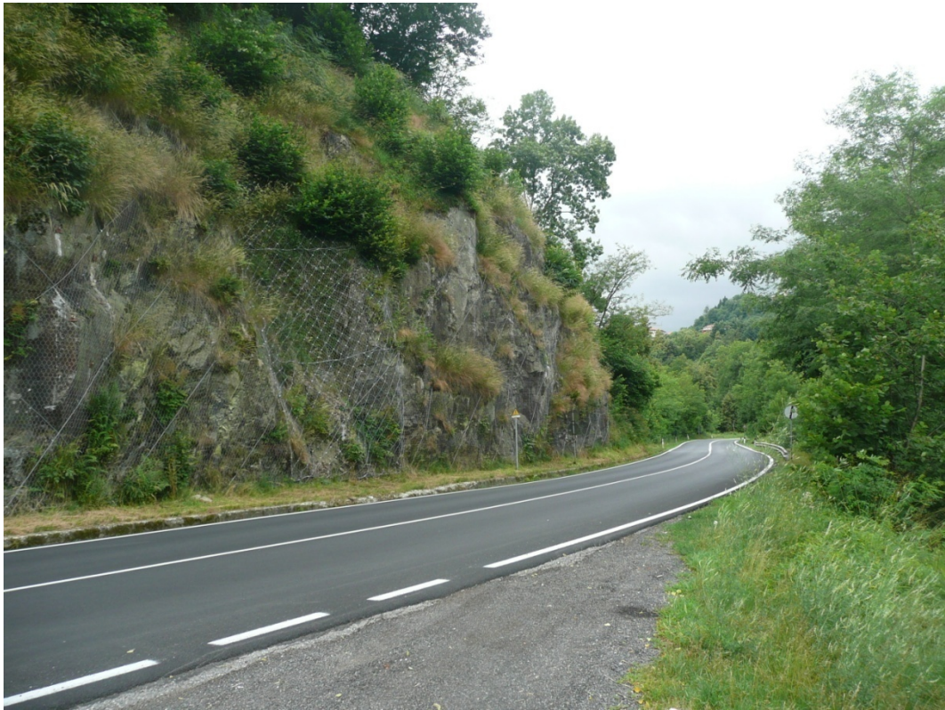
Tratto della S.P. 117 interessata dalla posa della condotta
