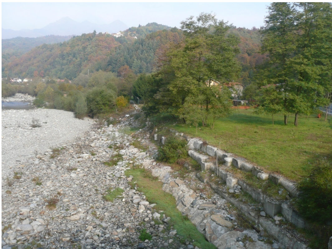
Tratto di area golenale del Sessera interessata dalla posa della condotta
