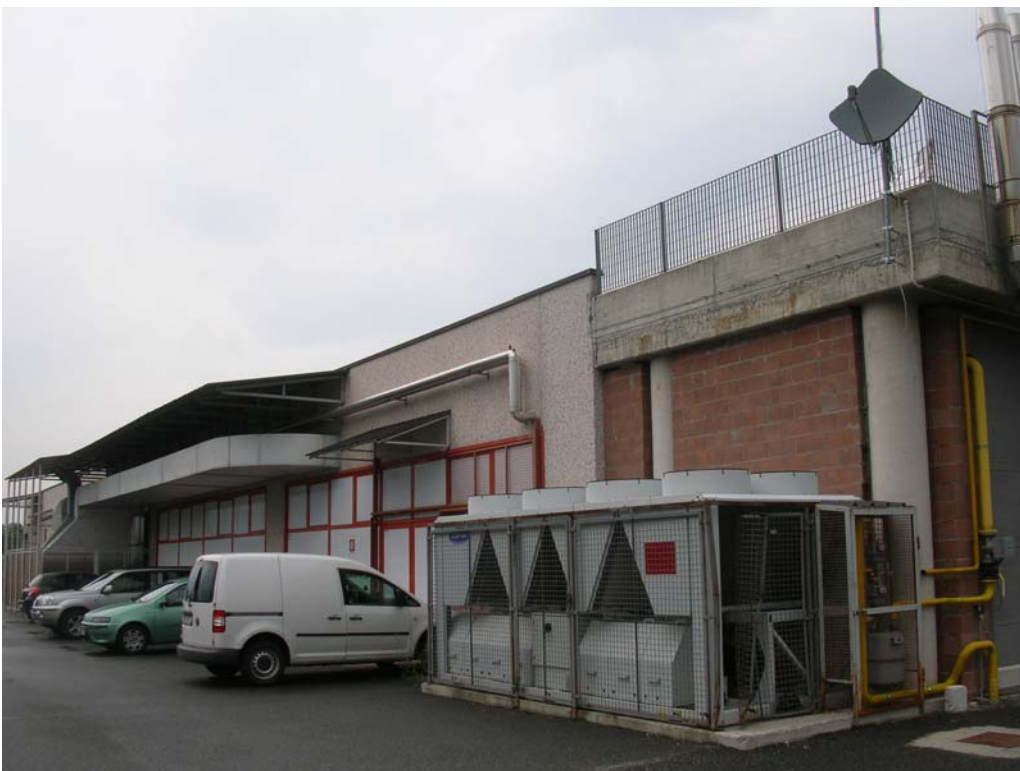
Figura 4: retro del supermercato oggetto dell'ampliamento nelle parti prefabbricate
