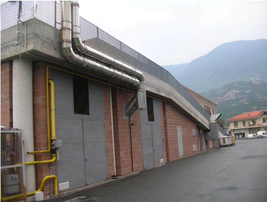
Figura 3: locali tecnici posti sotto il piano della rampa
