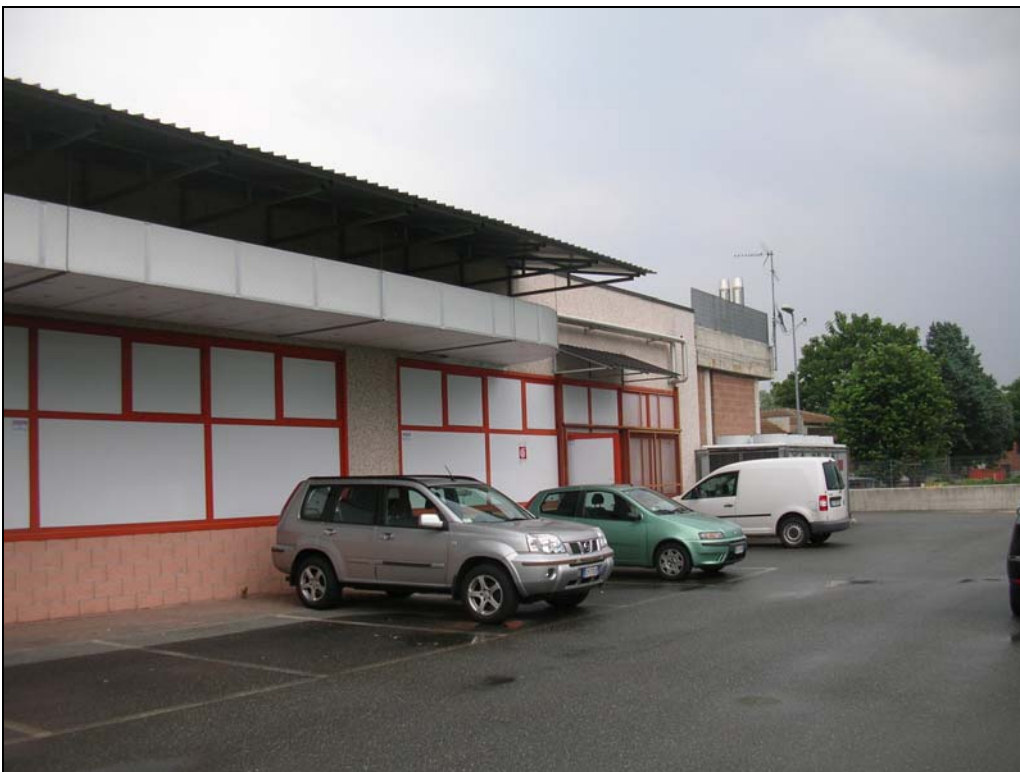
Figura 6: I pannelli di chiusura della parete saranno smontati e riportati sul nuovo fronte
