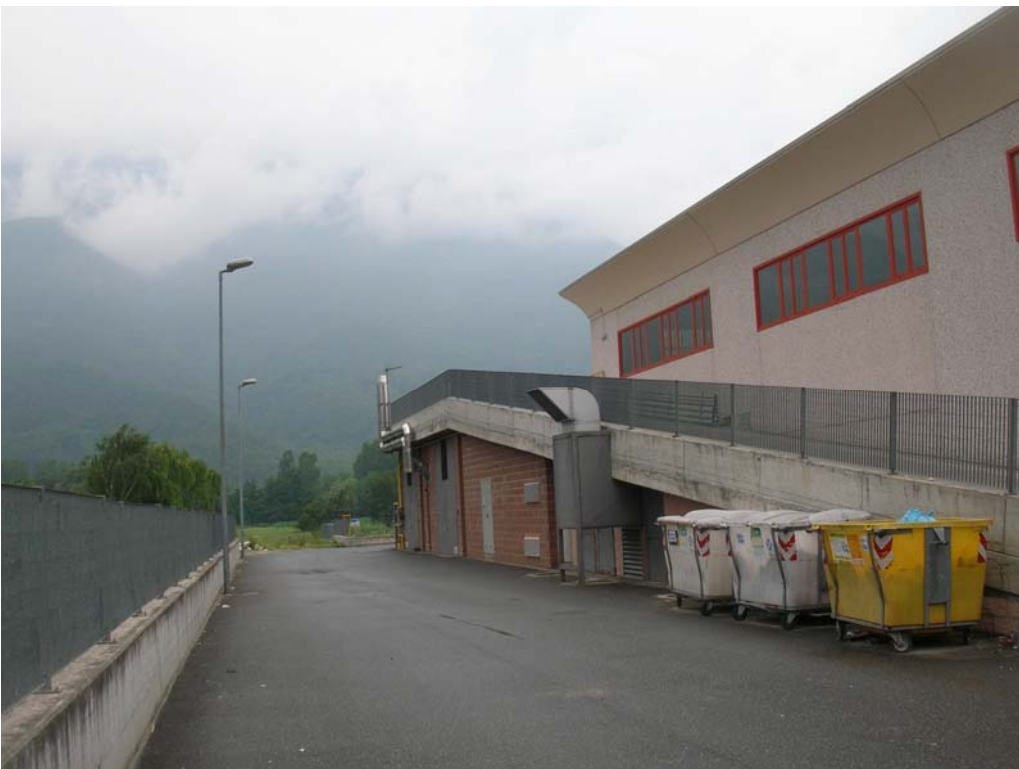
Figura 2: rampa di accesso al parcheggio di copertura
