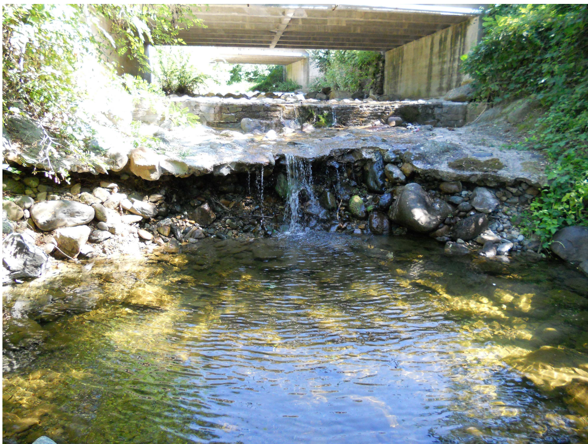
Erosione della platea di fondo
