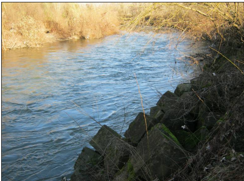
Foto 5 Prismi in cls a protezione della sponda sinistra in corrispondenza del meandro presso Cascina Lavaretta
