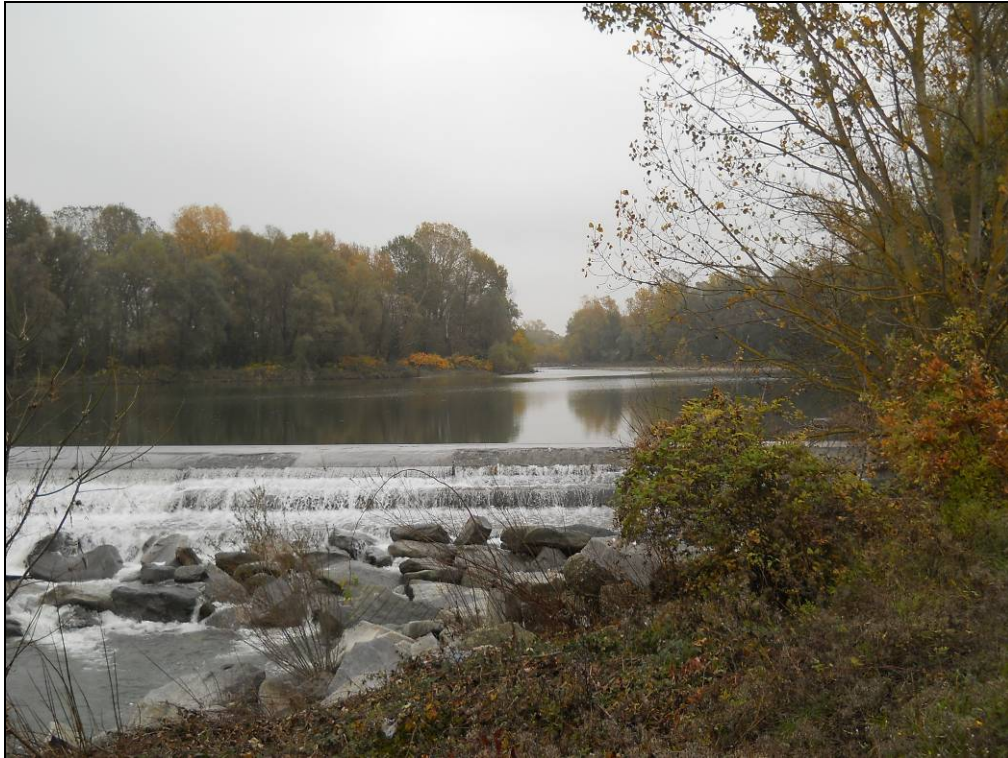
Foto 24 Vista da valle della traversa della Roggia S. Michele. Si osservi a tergo di detta opera il lungo tratto con acque quasi ferme che determina una banalizzazione dell'alveo fluviale pur in presenza di fasce riparie discretamente sviluppate
